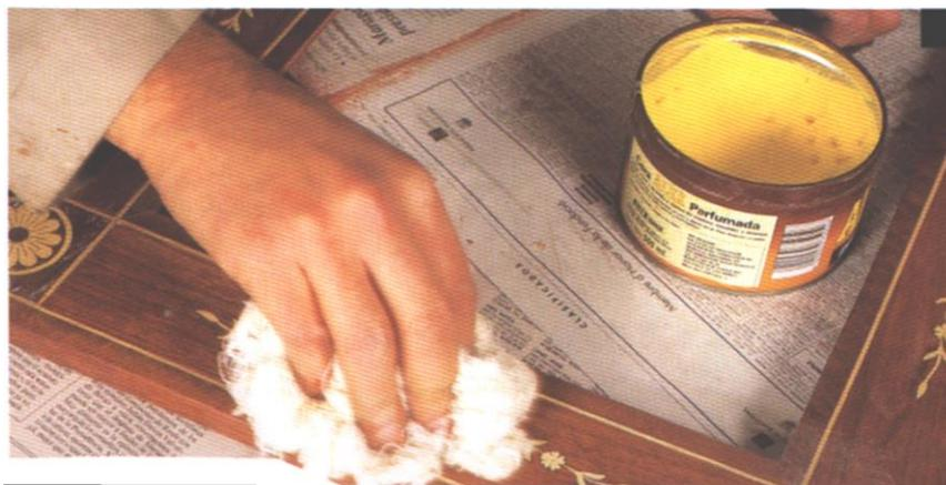
Ilustración 94 Aplicación de Cera con Cabos de Algodón.
